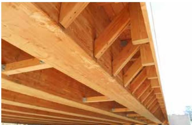
Pont de Cognin (73). Crédit Photo: Chambéry Métropole
