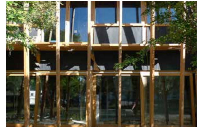
Bâtiment du CAUE de l'Aude (11)
