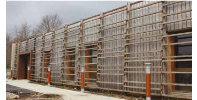
Maison de la forêt et du bois - Commune de Salvétat sur Agout (34)
