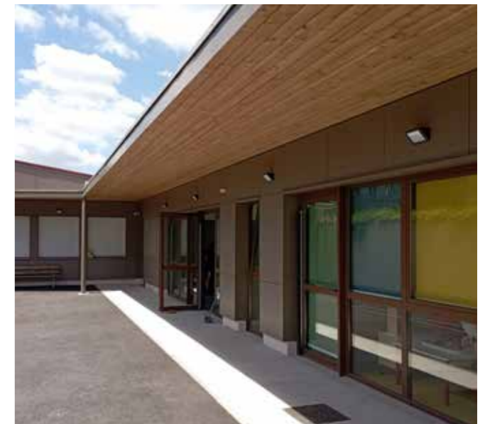
Groupe scolaire de Martres de Rivières (31)
