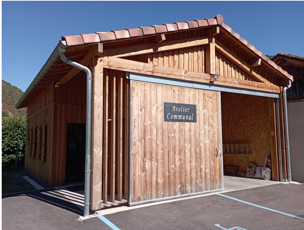
Façade principale des ateliers municipaux
