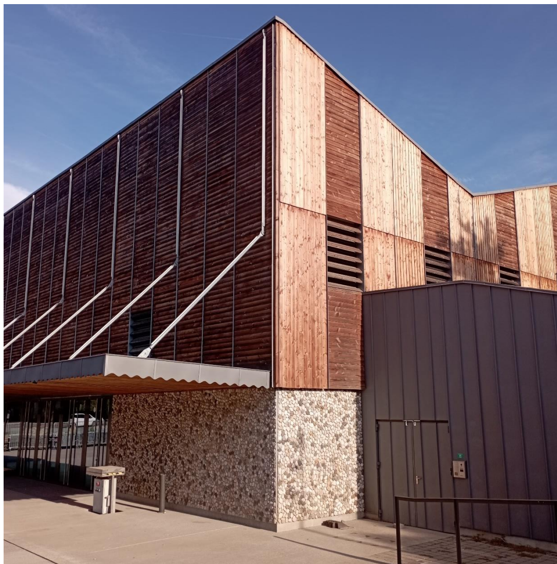
Vue extérieure du bâtiment
